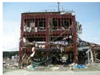
宮城県南三陸町防災対策庁舎
